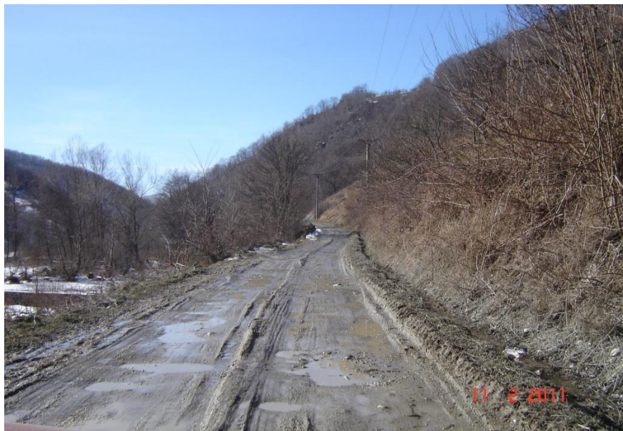
Drum Comunal DC 28 Cornereva – Camena, înainte de modernizare
