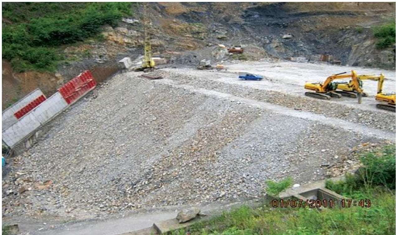
Lucrări la Amenajarea hidrotehnică Cerna - Belareca
